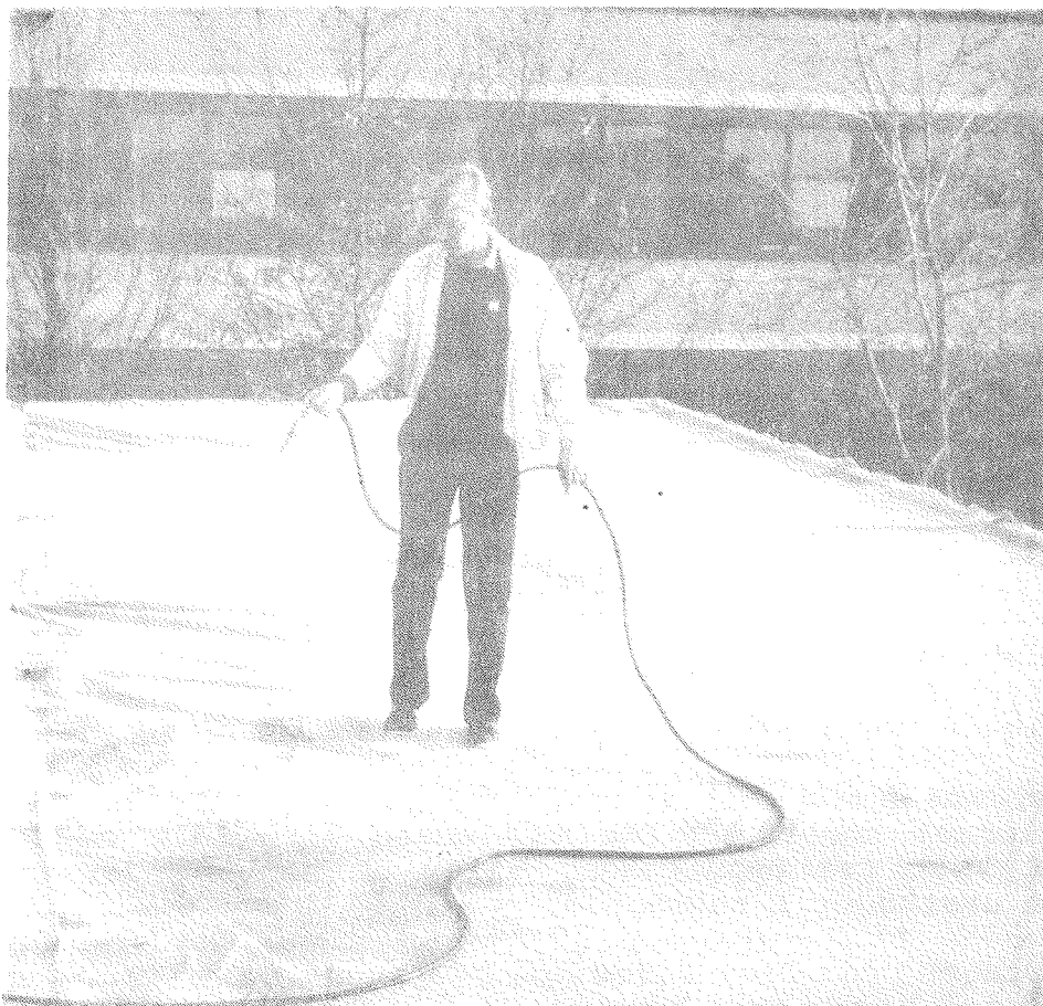
Figur 18 Tilsætning af vand til den del af taget, der blev renoveret med en Hygrodiode som dampbremse.
