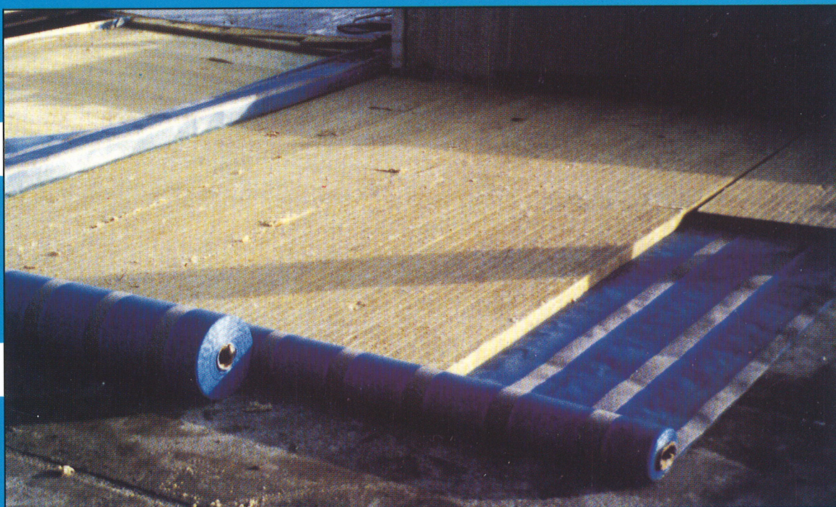
Varmt-tagskonstruktion med Hygrodiode dampbremse. Warm-deck roof system with Hygrodiode vapour retarder.
