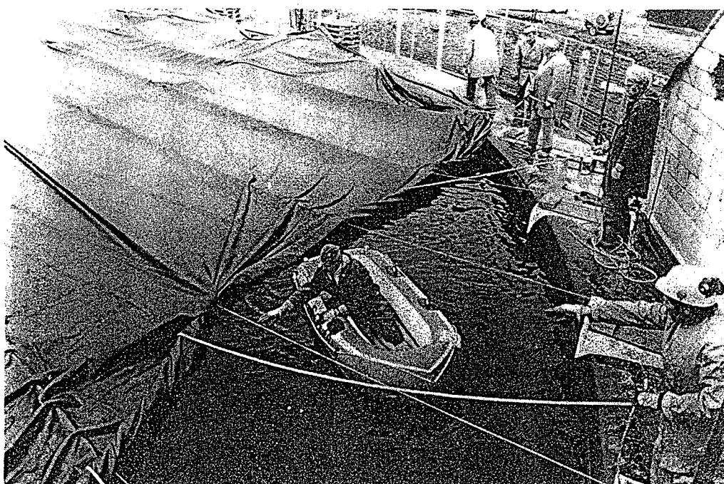
Figur 3.2: Montage av tätduk på lagret (med påfyllt vatten).
