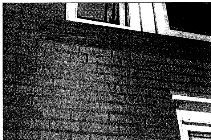
Nærbillede af den fugede og filtsede facade, de nye vinduer og inddækninger, en udkradset stødfuge, samt „vinduesoverligeren“.
