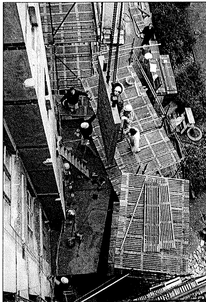
Fig. 10. Montage af dækelementer mv.
