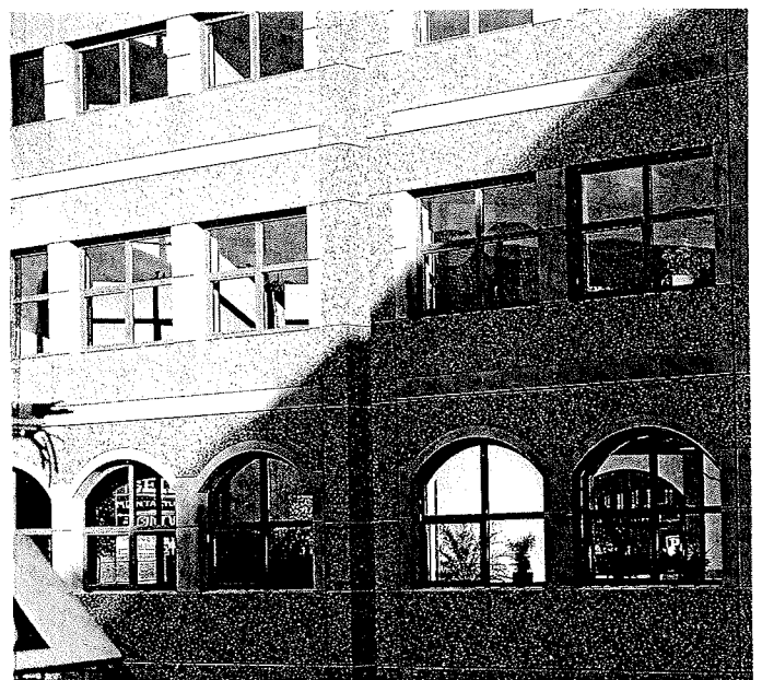
Foto 3. Facaden opbygges af 48M brede betonsandwichfacader adskilt af dy- be nicher. Overfladerne veksler mellem frilagt, afsyret og slebet beton i bånd omkring vinduer og udfor etagedækkene.
