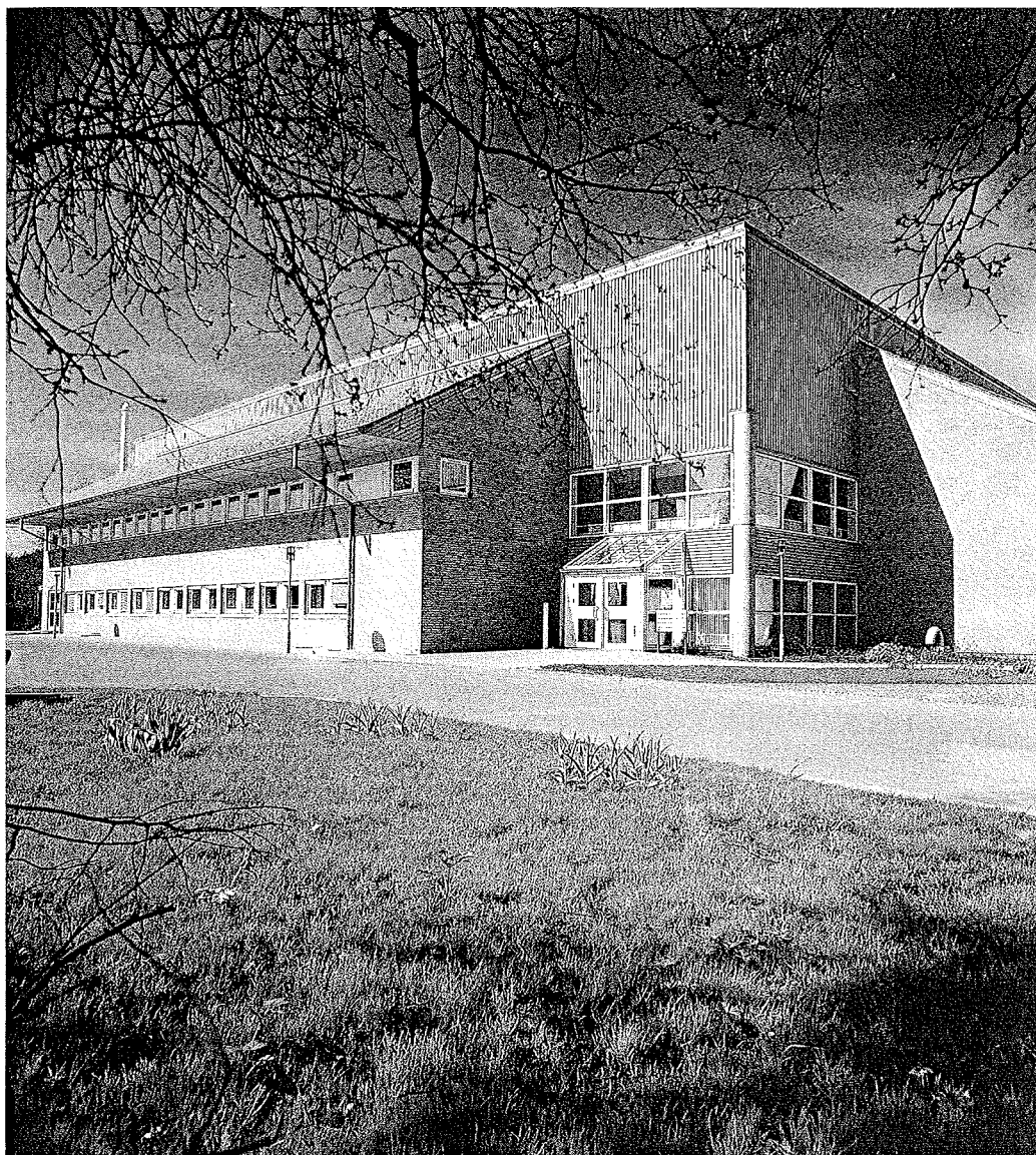
Fotos 1. Byggeriet set fra indgangspartiet. Det store tagudhæng giver solafskærmning på øverste etage.
