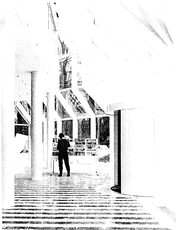
Fig. 5 b. Indgangsparti mod nord-øst med let stålkonstruktion og termoglas.
