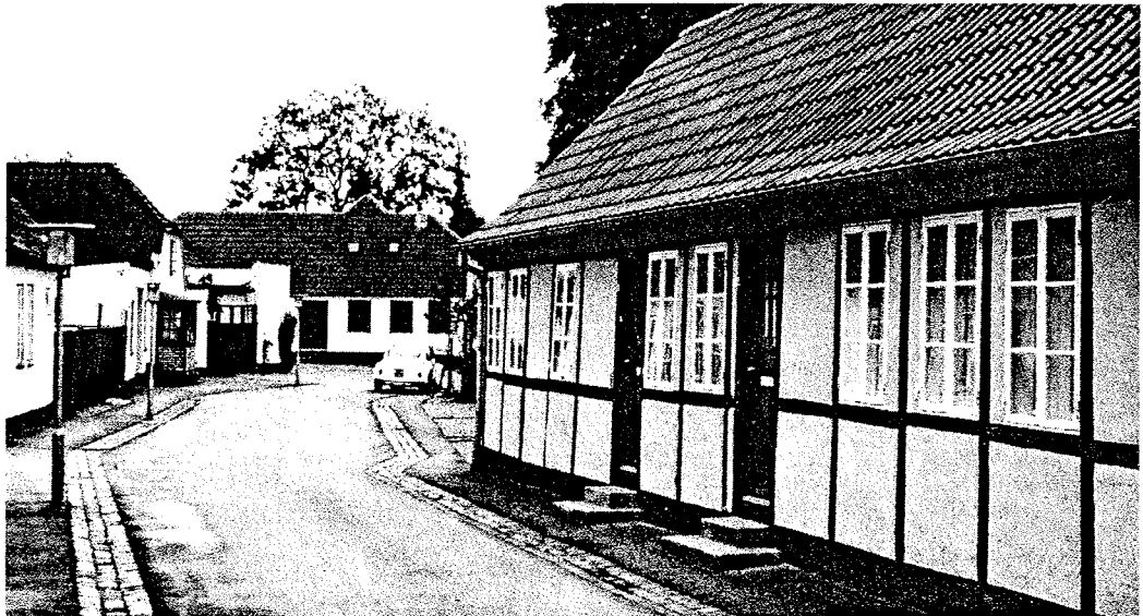
Figur 1. Torvet 30 er opført i 1700-tallet. De oprindelige bindingsværkswægge er skjult bag en nyere væg, som er placeret uden på den gamle. Alle kviste er nyere — specielt midterkvisten. I forbindelse med saneringen er tagbeklædningen udskiftet, medens facader og vinduer er istandsat. Øvrige indvendige forbedringer er omtalt i teksten.
