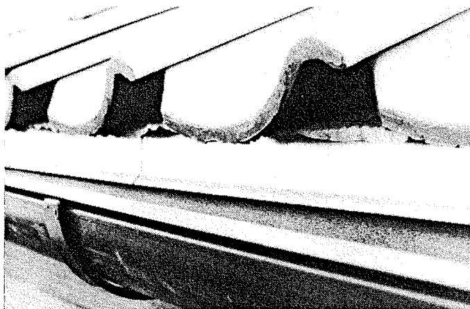
Fig. 11. Detalje af tagfoden med zinkplade, der både sikrer god afvanding, afløb af evt. smeltet tygesne under stenene og ventilation under undertag.
