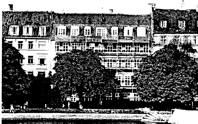
Fig. 1. Bygningens østfacade set fra Nørre Søgade. Bemærk sætningen af tagets rygning mod nord (til højre), foto HCP.
