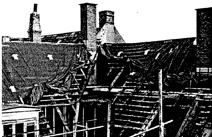
Fig. 7. Bygningens nordøstlige hjørne med fløjen mod Dosseringen til højre. Det lyse tømmer under pressenningen er den oplagte forstærkningsbjælke, foto BEC.
