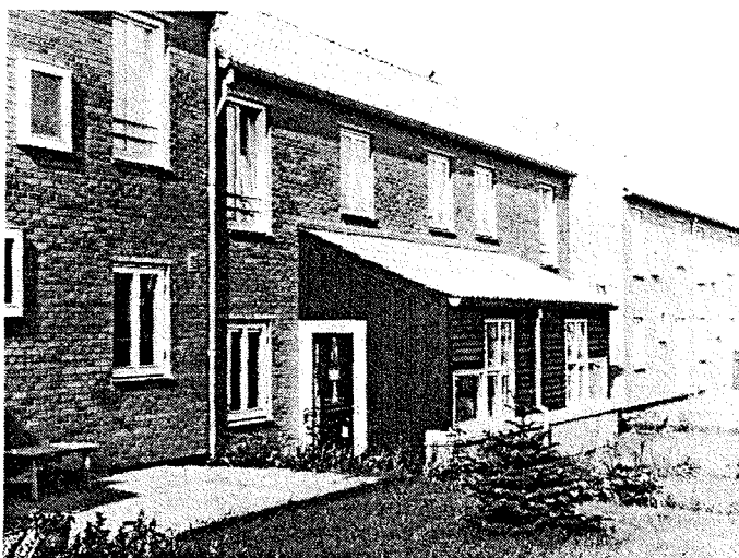
Fig. 7. Havefacaden af to etages boliger med stuekarnap. Endeknasten foroven giver et ekstra værelse til boligen vist på fig. 4 og 6. Bemærk brystningerne på karnapperne, se fig. 12 og 13, og de »udvendige« vinduer på det murede hus.
