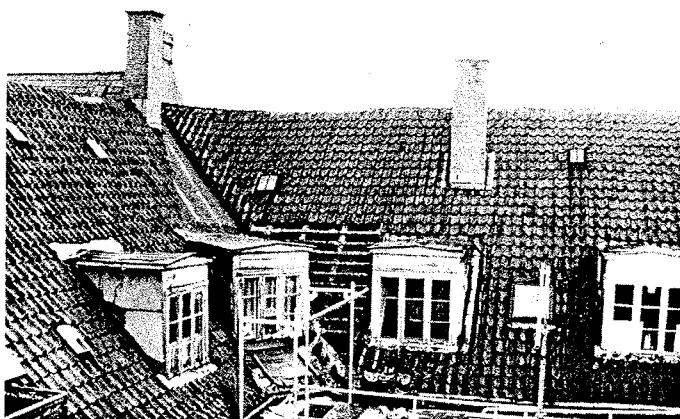
Fig. 5. Bygningens nordøstlige kehl, set fra gården. Bemærk sætningen af tagryggen og den brede skotrende, der skyldes en dobbelt kehlkonstruktion på grund af kvisten i hjørnet, foto HCP.
