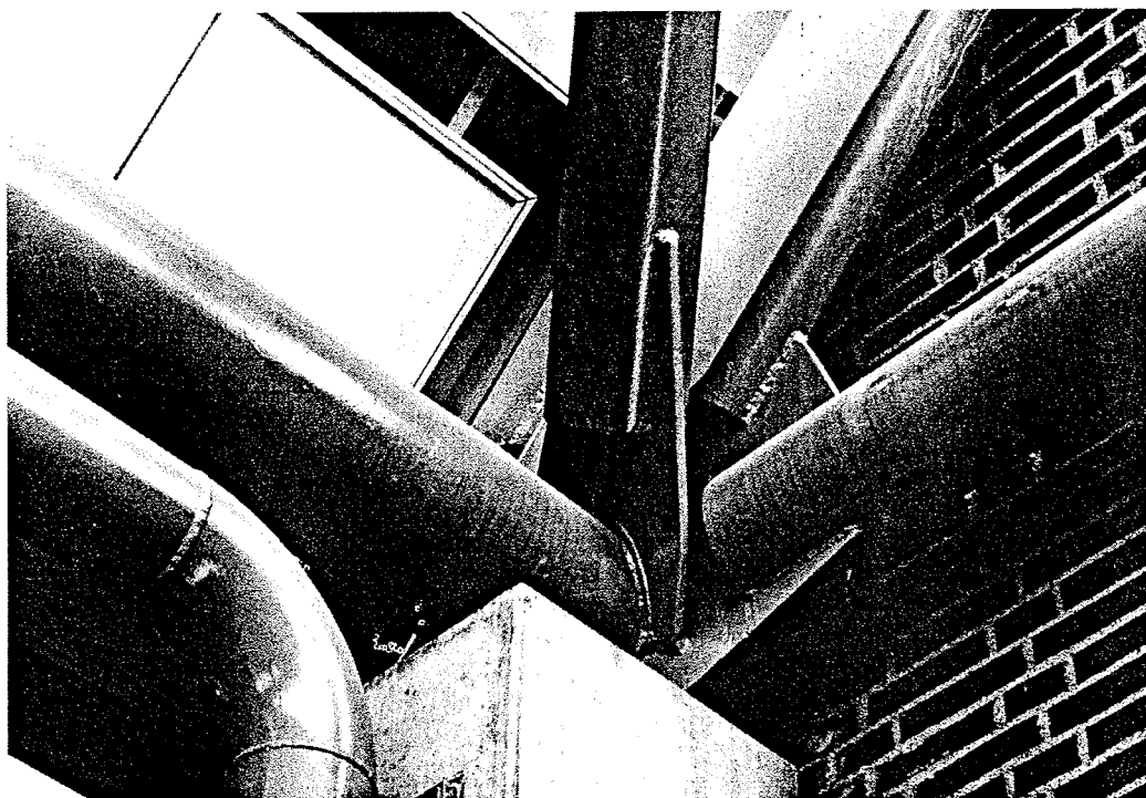
Fig. 6. Detalje af vederlag for hovedtagdrager. Bemærk diagonaltilslutningen, hvor knudepladen som en sadel går ned over flangerøret. Til venstre ses øverste hjørne af rørgalge, hvori langsgående rørbroer er ophængt. ►
