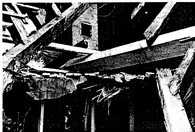
Fig. 8. Detalje af figur 7. Bemærk, at den højre del af den gamle kehl-konstruktion er fjernet, foto BEC.
