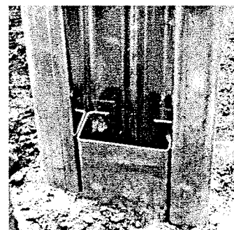
Fig. 8. Detalje af charnier ved rammefod.
