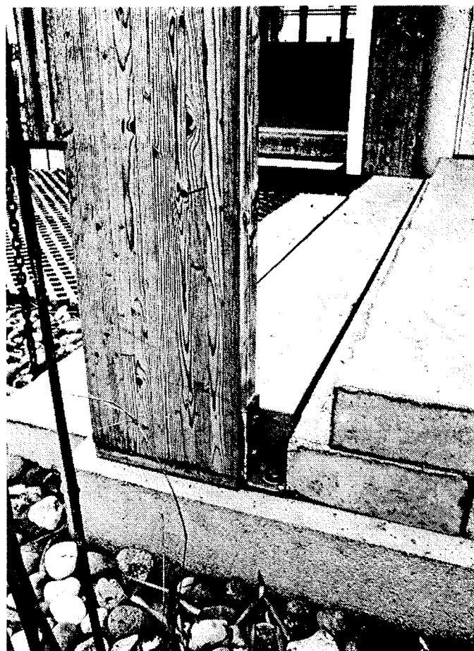
Fig. 10. Rammeben fra A-pavillon. Alle søjler har kun et beslag til fastgørelse i fundamentsbjælkerne, jævnfør figur 3.
