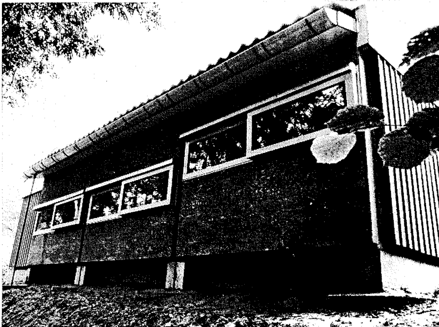
Fig. 13. Facade i linie L. Her ses tydeligt fundamentsbjælker og -planker samt punktfunderingen. Gavlelementerne er lodrette og har fået en profilering af lister. De 3 B-pavilloner har her tegltag.
