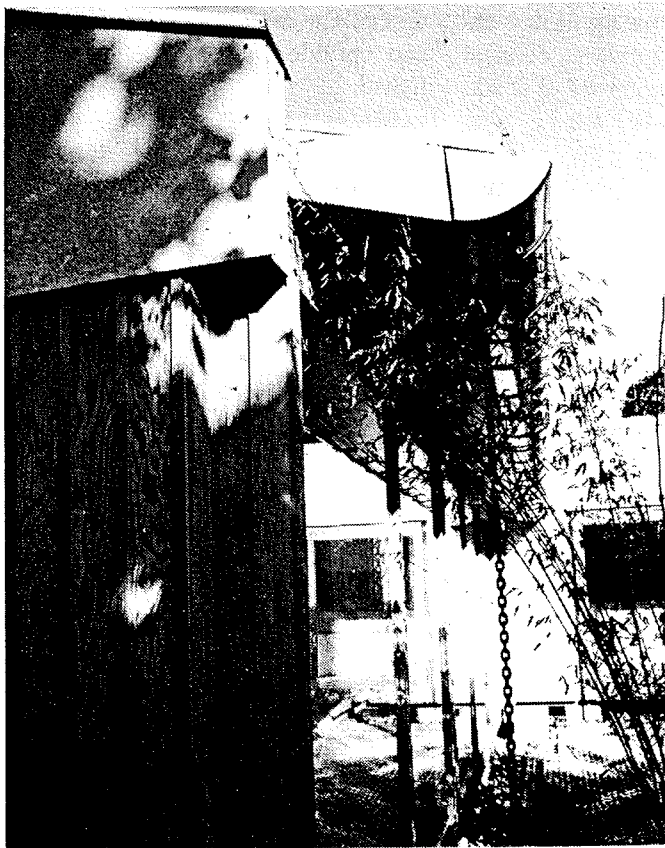
Fig. 7. Detalje fra skæringen mellem linierne H og 6. Aluminiumstagrenden er i bagsiden givet samme højde som tagelementet, hvorved der fremkommer et harmonisk linieforløb i undersiden af udhænget.
