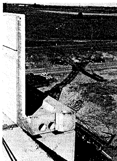
Fig. 8. Gesimselement i facaden.
